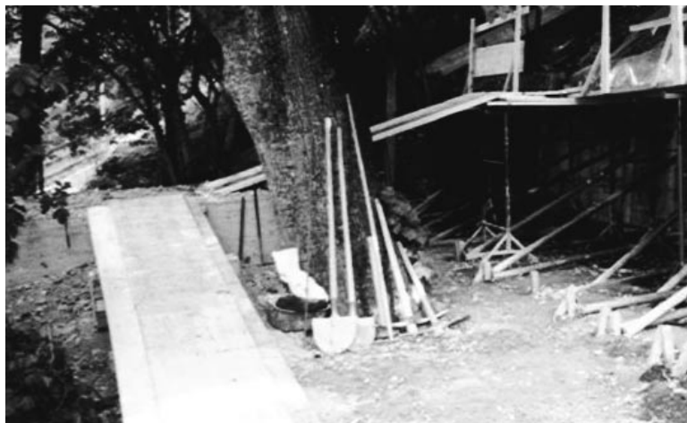
Die Stützmauer im Bau
