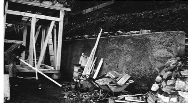
Fertige Stützmauer und Gartenhaus im Bau
