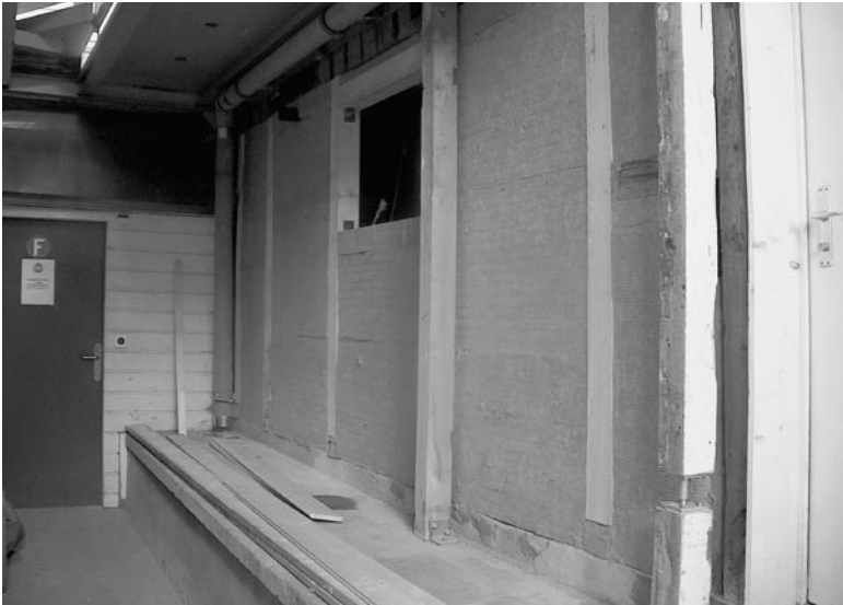
Tragkonstruktion fertiggestellt: Nun kann das Täfern beginnen
